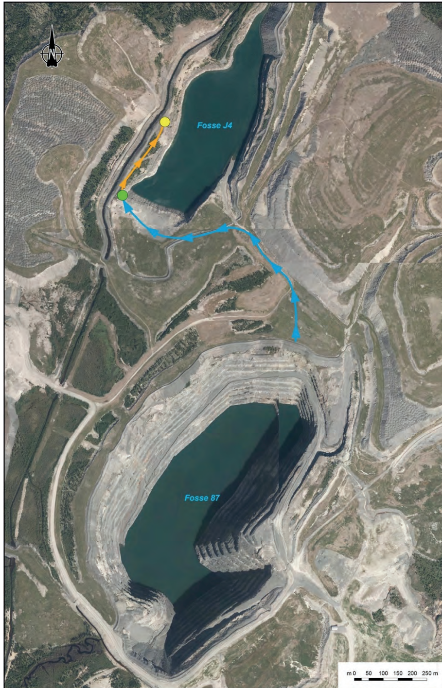
Figure 5.5 Localisation de l'usine de traitement (point vert) et du point de rejet (point jaune) et de la conduite de refoulement à partir de la fosse 87
